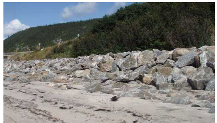
ENROCHEMENT (SOURCE HTTP://WWW.SECURITEPUBLIQUE.GOUV.QC.CA/ )
